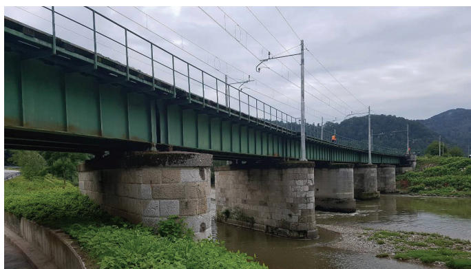
Slika 21 • Most pred sanacijo.
