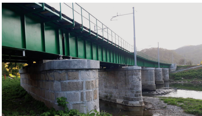
Slika 22 • Most po sanaciji.
