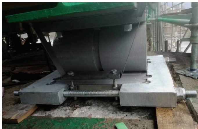
Slika 15 • Montaža objemnih jarmov in opaz na podlivanje ležišč.
