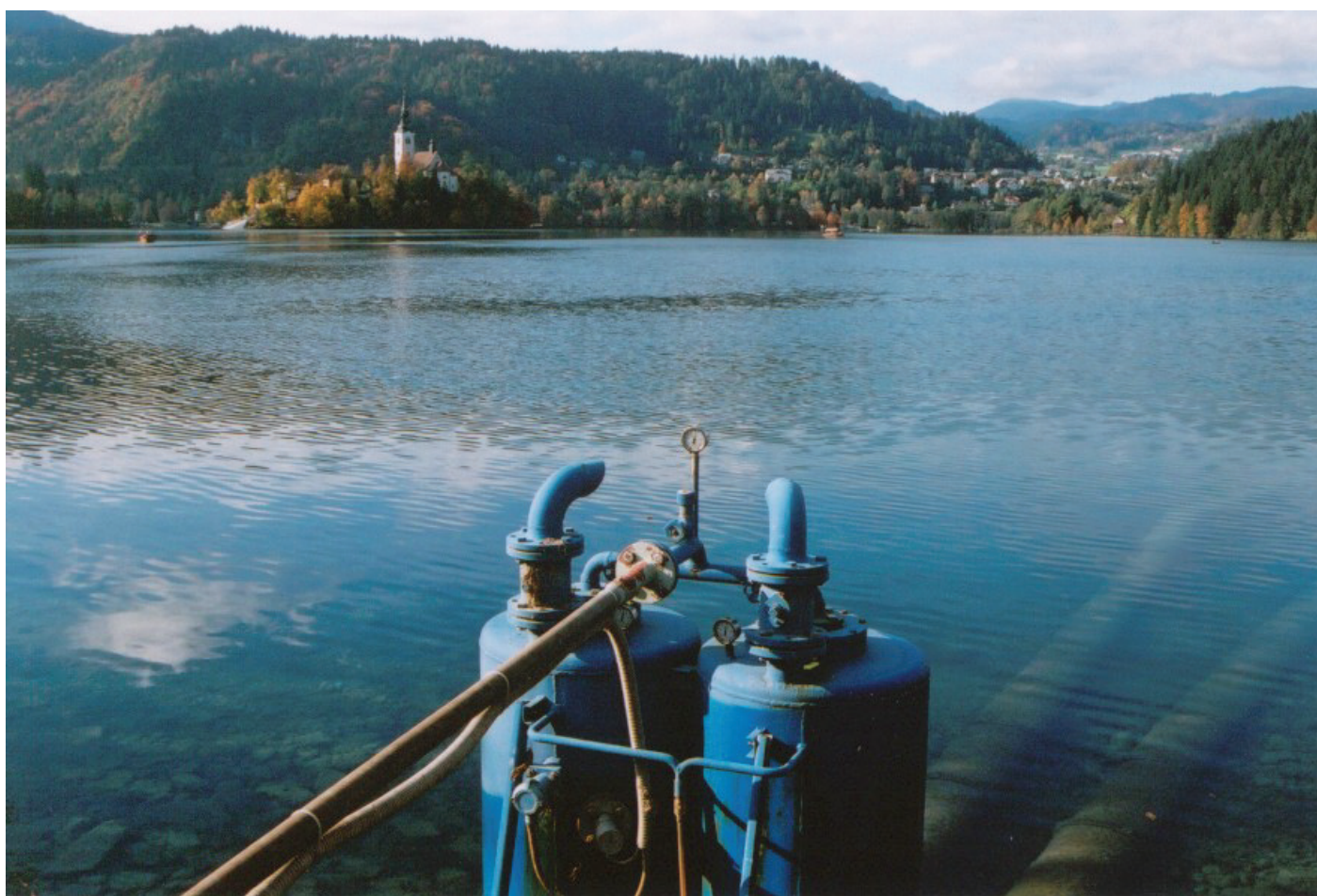
Slika 2 • Natega na Blejskem jezeru. Dva cevovoda (kraka natega) vlečeta anoksično vodo iz hipolimnija ven iz jezera, medtem ko sveža voda iz Radovne priteka v jezero.
