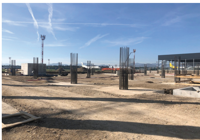
Slika 13 • Armatura AB-stebrov v pritličju.
