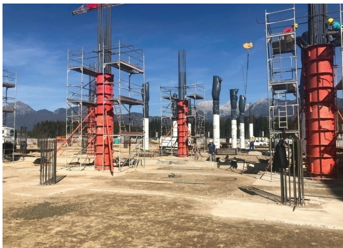
Slika 14 • Opaženje AB-stebrov.
