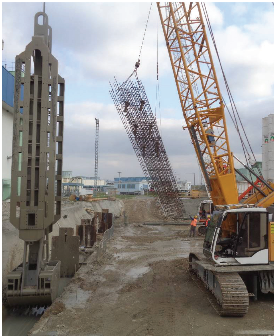
Slika 5 • Izkop za diafragma in vgradnja armaturnega koša.
