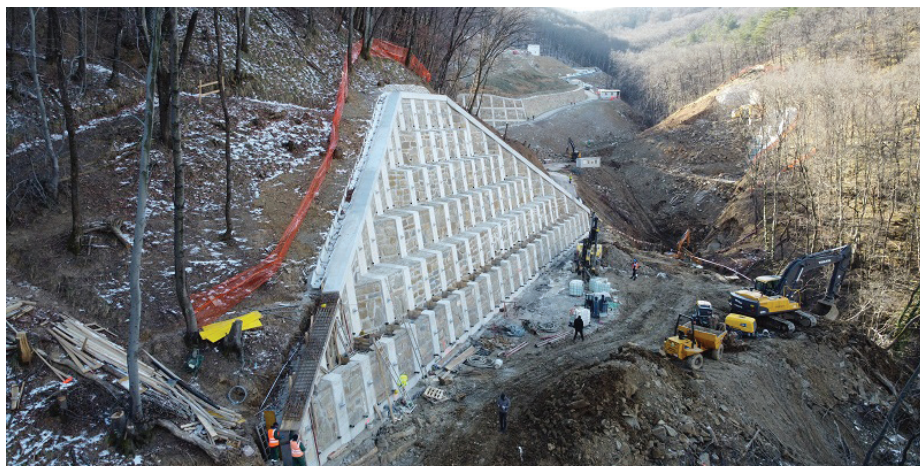
Slika 2 • Oporni zid ob osrednjem delu premostitvenega objekta.
