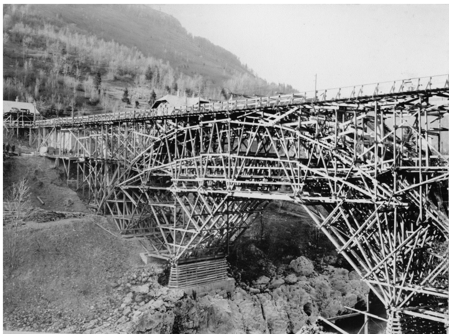
Slika 6 • Podporni oder mostu čez Idrijco malo pred betoniranjem loka decembra 1905. Foto: arhiv Tolminskega muzeja
