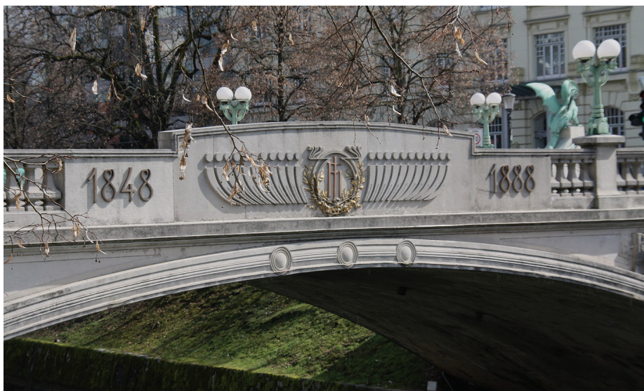
Slika 13 • Zmajski most v Ljubljani iz leta 1901, ki je iz armiranega betona po sistemu Melan in ima čudovito secesijsko arhitektonsko podobo. Foto: Gorazd Humar
