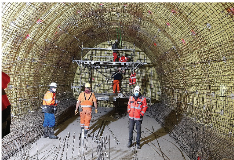
Slika 5 • Armatura oboka v novih oz. razširjenih tehničnih prostorih (nišah). Foto: arhiv Direkcije RS za infrastrukturo
