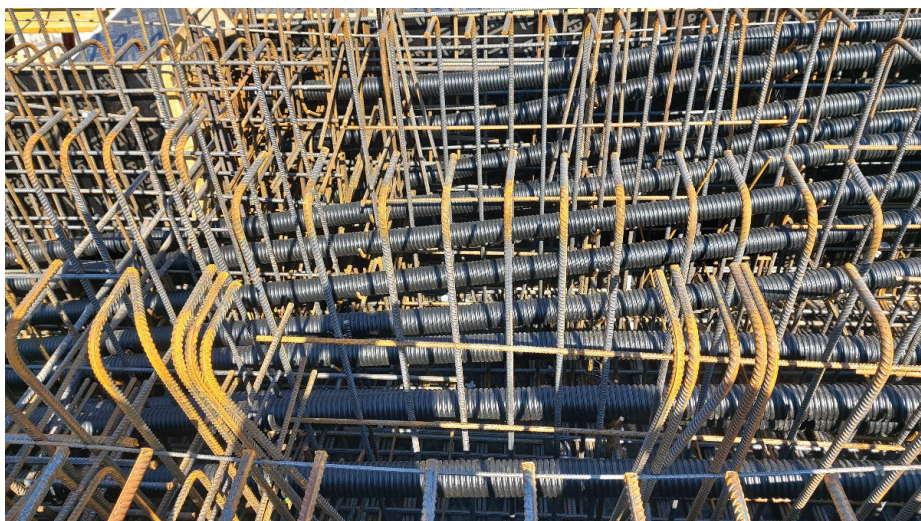
Slika 4 • Kabelske cevi in armatura rebra, junij 2021.
