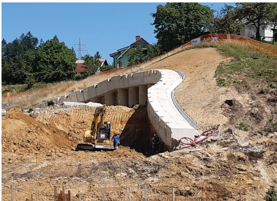
Slika 4 • Oporna konstrukcija 10-OK-14 (pilotna stena).
