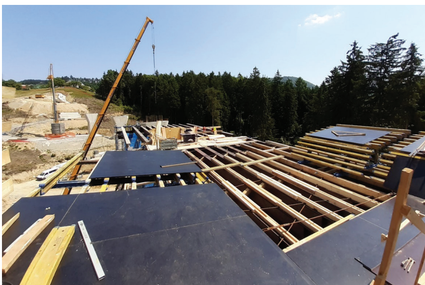
Slika 2 • Montaža opaža prvega polja prekladne konstrukcije nadvoza 4-03.
