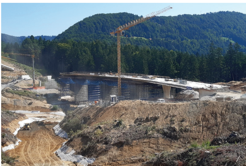
Slika 1 • Nadvoz 4-03 preko hitre ceste v priključku Gaberke.
