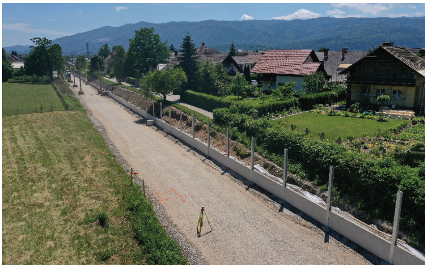
Slika 7 • Trasiranje proge skozi Lesce. Foto: arhiv Direkcije RS za infrastrukturo.
