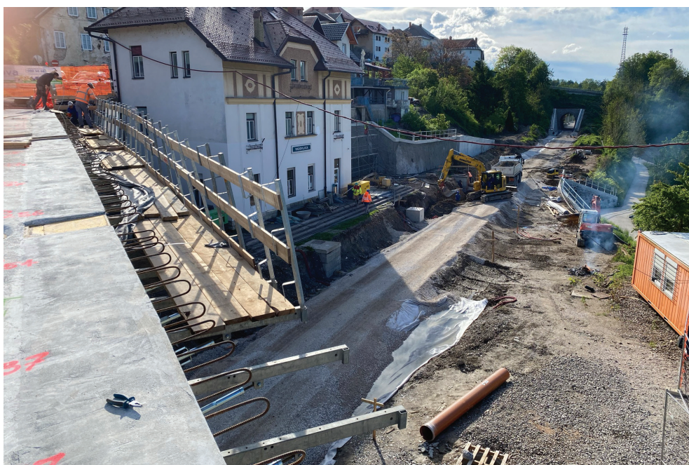
Slika 3 in 4 • Izgradnja novega nadvoza čez železniško progo v Radovljici. Foto: arhiv Direkcije RS za infrastrukturo.
