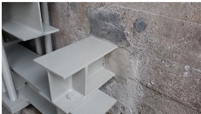
Slika 8. Sidranje v betonski opornik.
