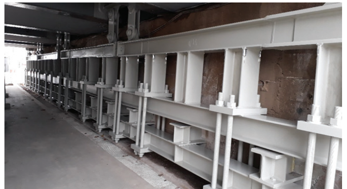
Slika 4a. Novi sistem sidranja v krajni opornik.
