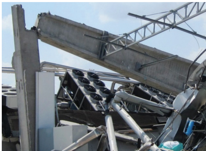
Slika 1. Glavni konstrukcijski sistem hale je razpadel, ker ni bilo mehanskih povezav med stebri in gredami.
