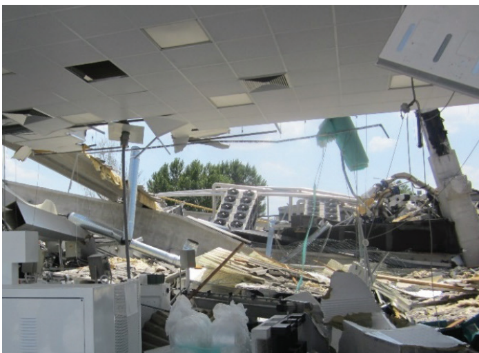
Slika 1. Glavni konstrukcijski sistem hale je razpadel, ker ni bilo mehanskih povezav med stebri in gredami.
