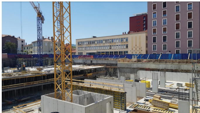
Slika 15. Pogled na gradbeno delovišče, april 2020.
