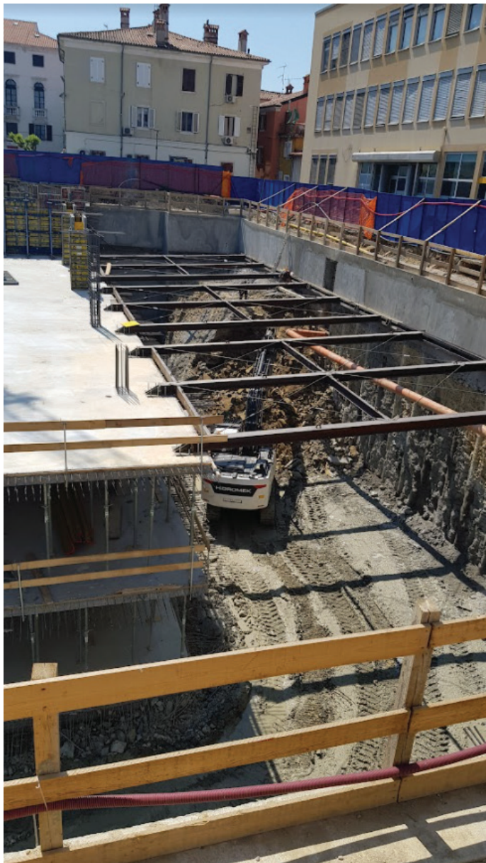
Slika 14. Razpiranje gradbene jame, april 2020.
