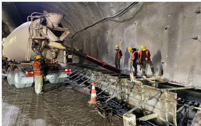
Slika 7. Betoniranje temeljev notranje obloge predora.
