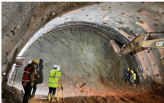
Slika 5. Montaža jeklenega loka (palični nosilec).
