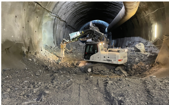
Slika 6. Izkop za talni obok iz brizganega betona.
