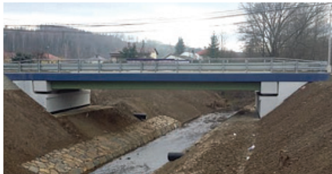
Slika 1. Spodnji del kompozitnega nosilca, pripravljen v delavnici (levo), in hibridni sovprežni most, sestavljen iz spodnjega FRP-nosilca in tlačne AB-plošče, čez reko Ryjak na Poljskem (desno) [Siwowski, 2019].
