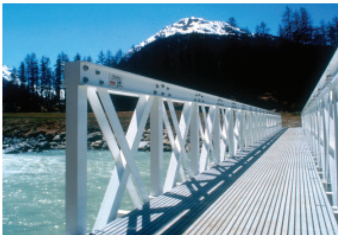
Slika 2. Most za pešce v Pontresini (levo) [Keller, 2016] in most za pešce v Lleidi čez železnico [Structurae, 2021], ki sta v celoti narejena iz profilov, narejenih iz armirane plastike in povezanih z vijačnimi spoji.
