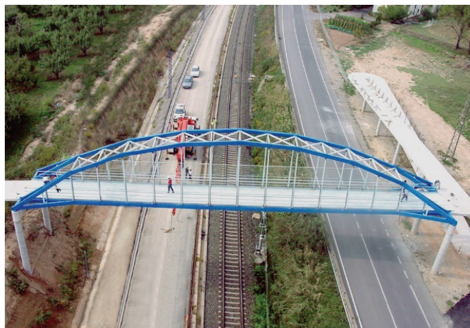
Slika 2. Most za pešce v Pontresini (levo) [Keller, 2016] in most za pešce v Lleidi čez železnico [Structurae, 2021], ki sta v celoti narejena iz profilov, narejenih iz armirane plastike in povezanih z vijačnimi spoji.
