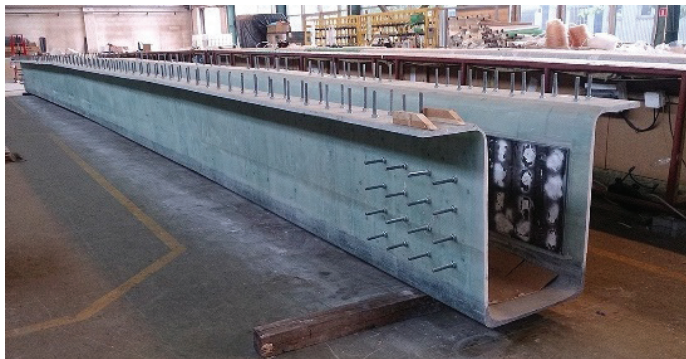
Slika 1. Spodnji del kompozitnega nosilca, pripravljen v delavnici (levo), in hibridni sovprežni most, sestavljen iz spodnjega FRP-nosilca in tlačne AB-plošče, čez reko Ryjak na Poljskem (desno) [Siwowski, 2019].
