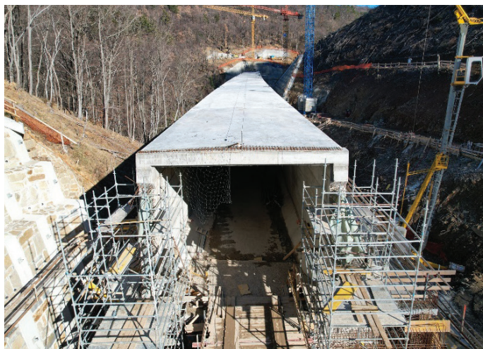
Slika 5 in 6. Viadukt Glinščica v avgustu ob začetku betoniranja in danes, ko je zgrajena zaprta škatlasta konstrukcija, namenjena varovanju narave in preprečitvi iztiranja vlaka.
