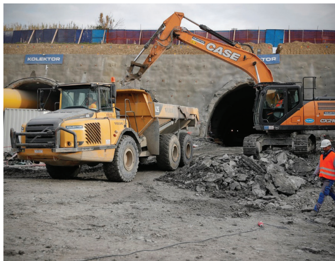
Slika 12. Gradbišče predora Škofije (T8) z južne strani.
