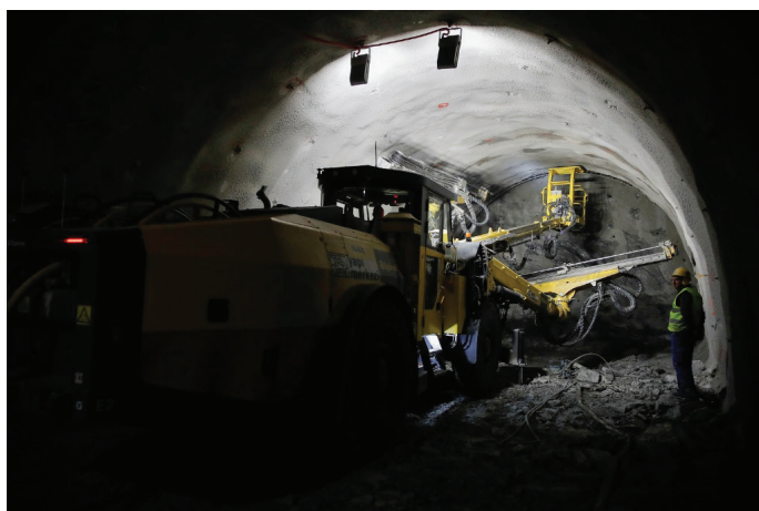
Slika 10. Gradnja predora Mlinarji (T7).
