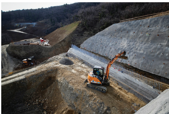
Slika 9. Gradnja dostopnih cest in območij predorskih portalo med predoroma Mlinarji (T7) in Osp (T5-6).
