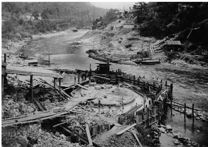
Slika 3. Izdelava temeljev obeh stebrov v strugi Soče poleti leta 1904. Temelji so bili izdelani iz betona. Foto: arhiv Tolminkskega muzeja [Tolminkski muzej, 2020].
