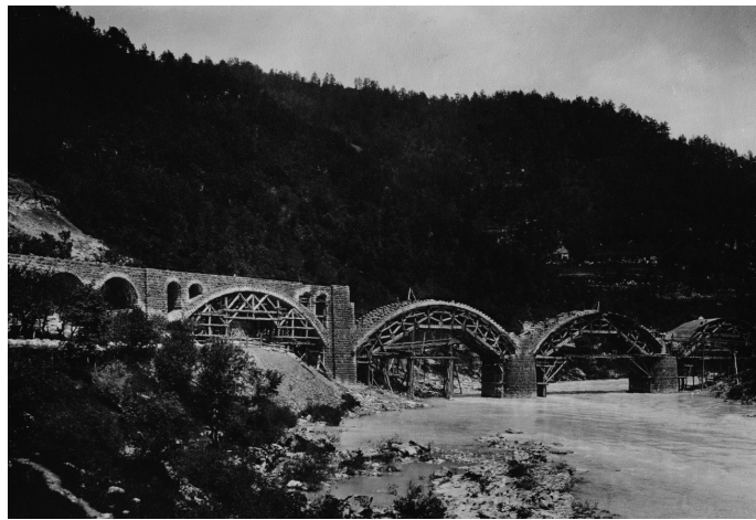
Slika 4. Gradnja kamnitih lokov je potekala postopno s podpiranjem na lesenih podpornih odrih. Posnetek je nastal julija 1905. Foto: arhiv Tolminkskega muzeja [Tolminkski muzej, 2020].
