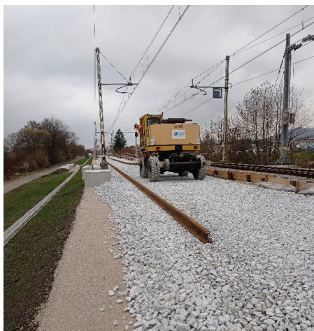
Slika 3. Priprava tirnic na razgrnjeni tolčenec – levi tir.
