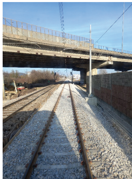
Slika 8. Nadgrajeni levi tir na odseku Ljubljana–Brezovica.
