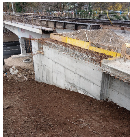
Slika 5. Sanacija železniškega nadvoza na Celovški cesti.
