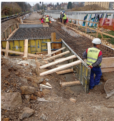
Slika 4. Sanacija podhoda pri parkirišču Tobačna.
