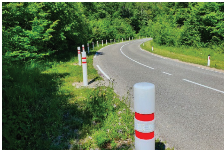
Slika 8. Pravilna postavitev in gabaritna oblika pasivno varnega stebrička.
