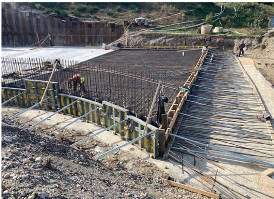
Slika 4. Armatura temeljne plošče (oktober 2021).
