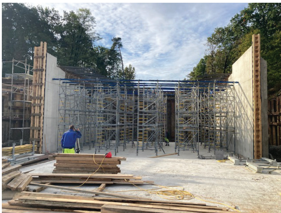
Slika 3. Postavljanje podporne konstrukcije za prekladno konstrukcijo (oktober 2021).
