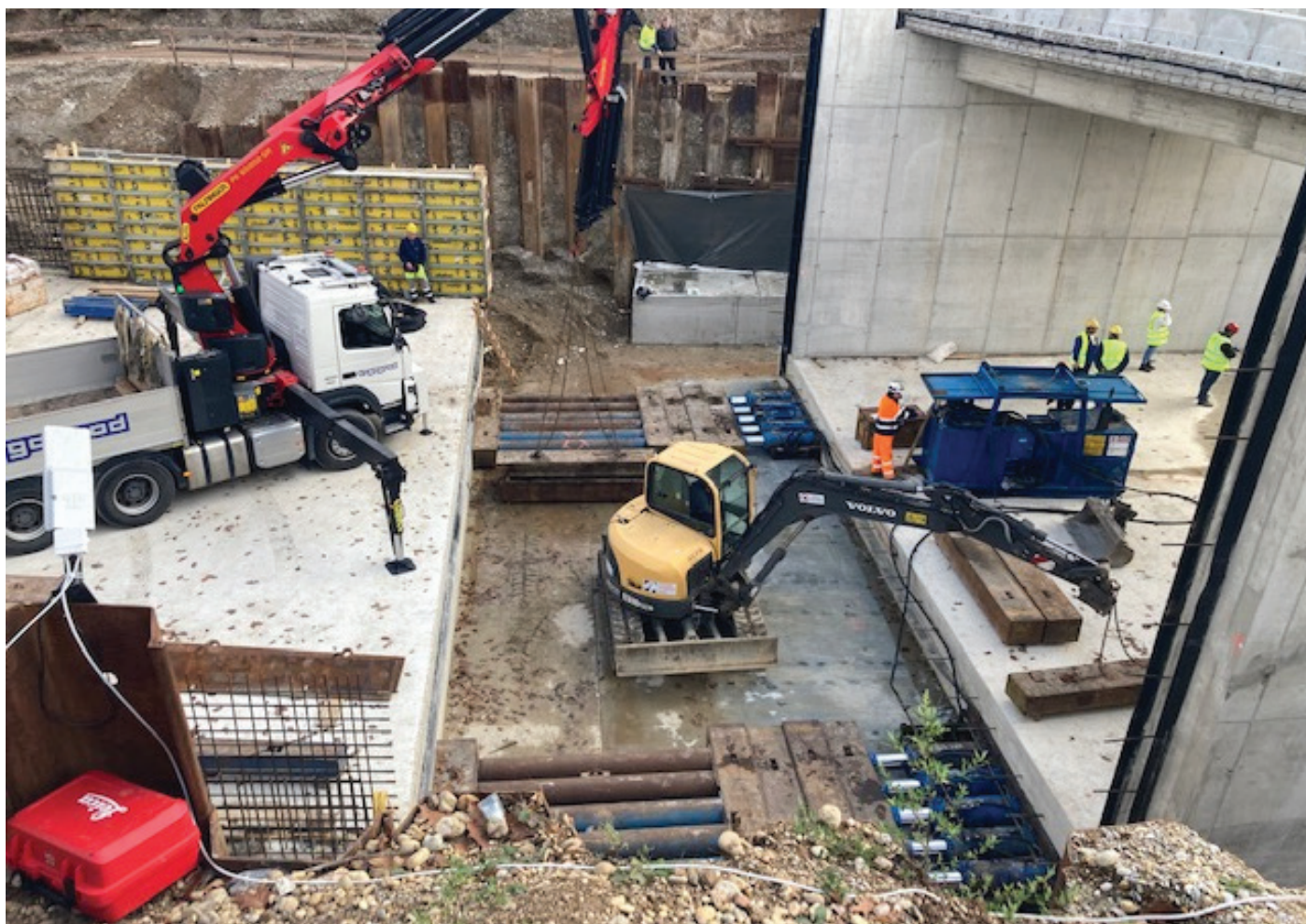
Slika 1. Potiskanje podvoza (november 2021).
