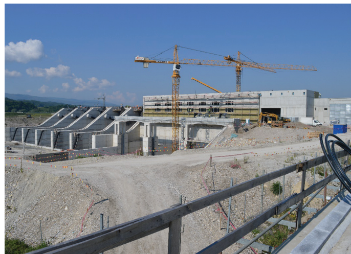
Slika 6. Meritve v času gradnje.
