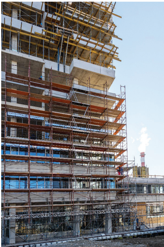
Slika 6. Prikaz razgibane armiranobetonske konstrukcije, februar 2022.
