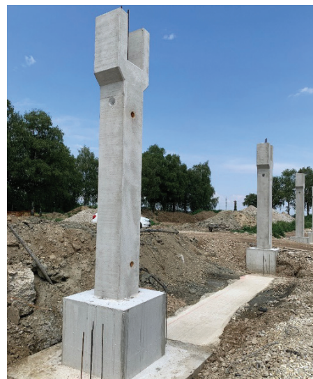
Slika 3. Vgrajena AB-člaš v peto temelja in montažni AB-steber.
