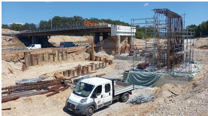
Slika 6. Zavarovanje izkopa gradbene jame, temelj in stena novega nadvoza čez HC. Na stari nadvoz se bo priključil nov nadvoz, avgust 2022.
