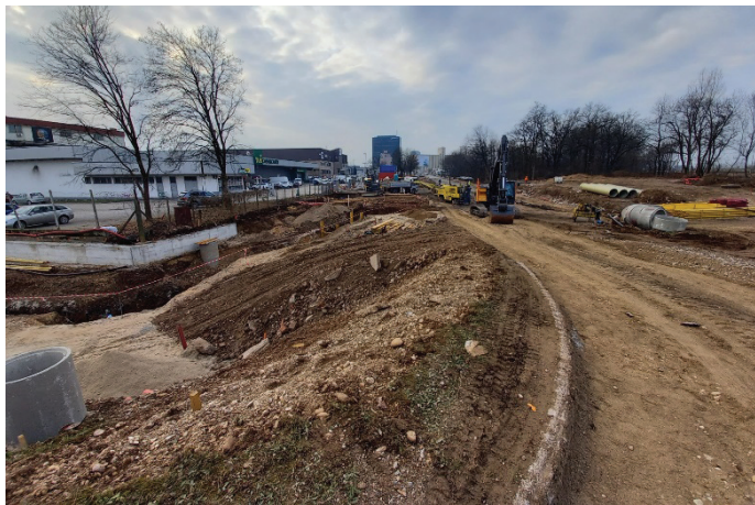
Slika 3. Pripravljalna dela, pogled na Leskoškovo zahod, november 2021.
