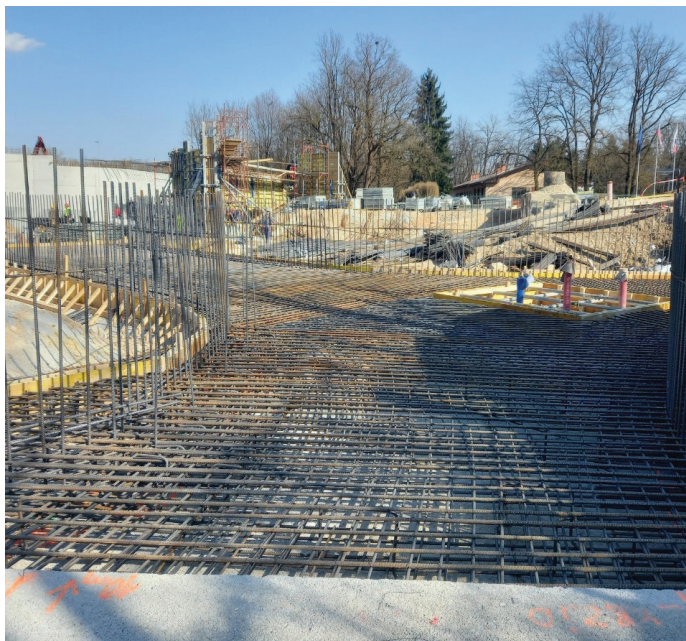
Slika 5. Temeljenje, južno krožišče, marec 2022.
