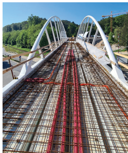
Sliki 16 in 17. Montaža jeklenih dvigalnih jaškov in armiranje voziščne plošče, maj 2022 (Foto: Ponting, d. o. o.).
