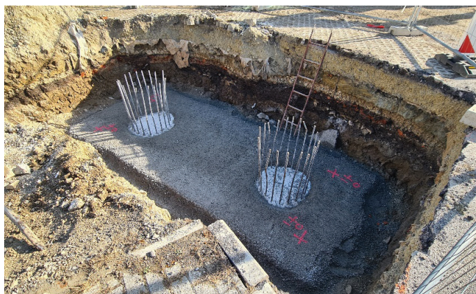
Slika 2, 3 in 4. Izvedba temeljenja – piloti in pilotne grede, oktober 2021 (Foto: Ponting, d. o. o.).
