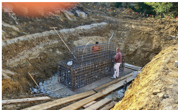
Slika 2, 3 in 4. Izvedba temeljenja – piloti in pilotne grede, oktober 2021 (Foto: Ponting, d. o. o.).
