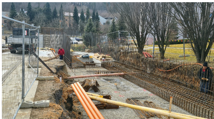
Sliki 7 in 8. Izvedba opornih zidov severnega dostopa in temeljev dvigalnih jaškov, januar–februar 2022 (Foto: Ponting, d. o. o.).
