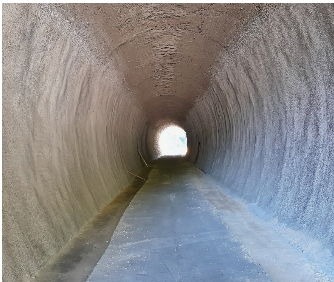
Slika 3. Sanacija obstoječega predora Paka 1, september 2022.
