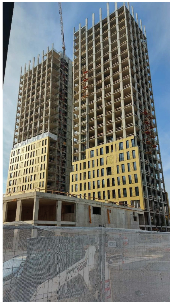
Slika 15. Zaključek gradbenih del, oktober 2022.
