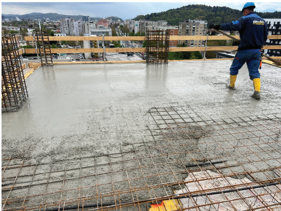
Slika 11. Betoniranje plošče, april 2022.
