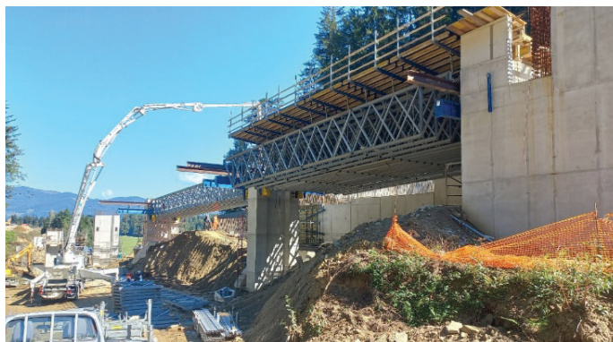
Slika 7. Podkonstrukcija 1. in 2. polja viadukta Visočnik, september 2022 (Foto: DARS, d. d.).
