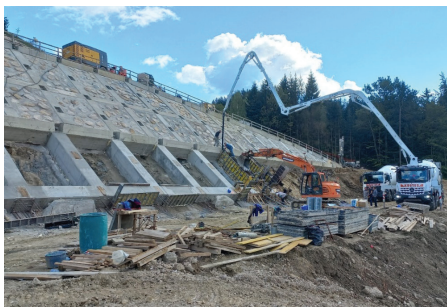
Slika 11. Betoniranje vertikalnega slopa na zgornji etaži oporne konstrukcije 10_OK-40, september 2022 (Foto: DARS, d. d.).
