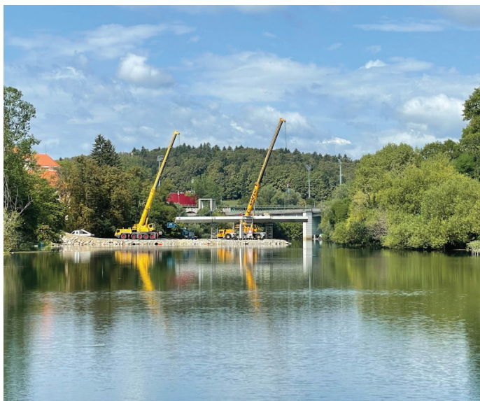
Slika 6. Montaža prvih segmentov, avgust 2022 (foto: Karol Žužek).
