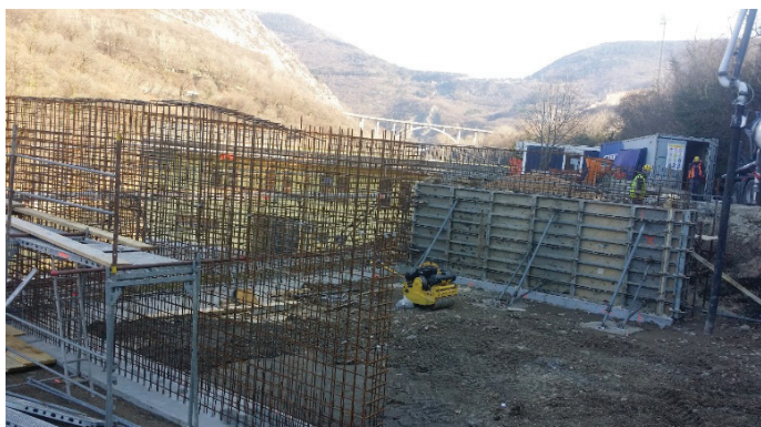
Slika 5. Izdelava levega krajnega opornika in izvedba zasipa s komprimacijo kamnitega materiala.
