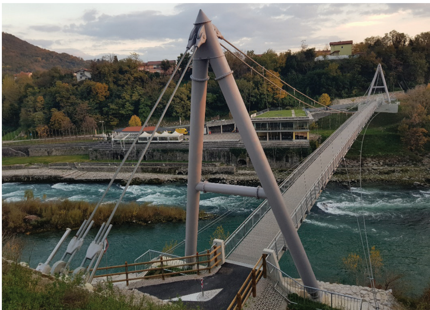
Slika 2. Zaključena montaža brvi.
