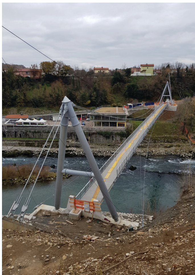
Slika 17. Zaključena montaža brvi in izvedena regulacija loka.
