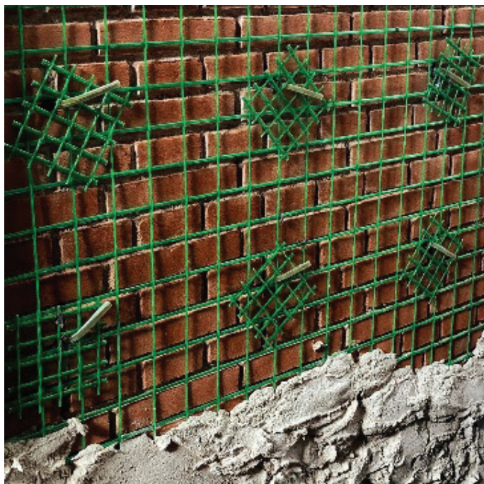
Slika 1. Mreža iz steklenih vlaken in sidra pred nanosom maltne obloge.
