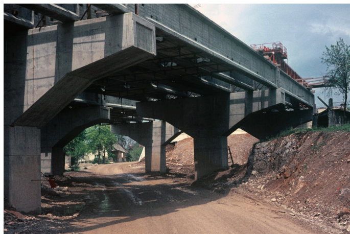
Slika 8. Gradnja viadukta Ivanje selo. (Vir: Fotoarhiv DARS).
