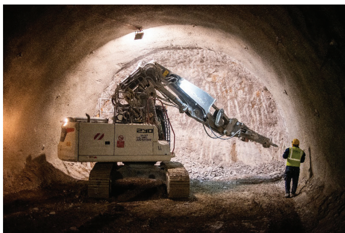
Slika 3. Izkopna dela v predoru Beka (T2).
