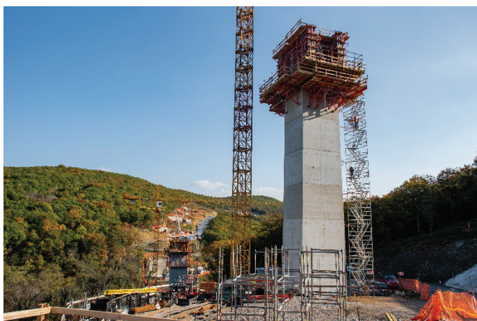
Slika 13. in 14. Segmentna gradnja stebrov viadukta Vinjan.
