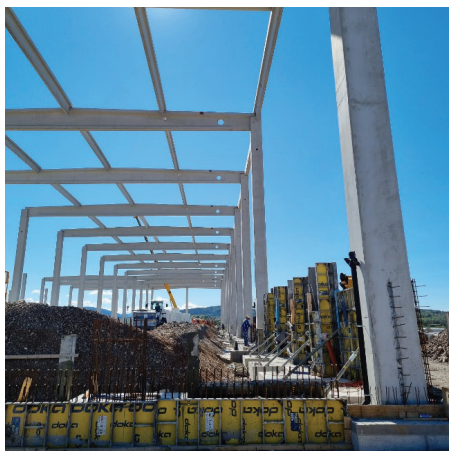
Slika 7. Izvedba parapetnih zidov okoli objekta.
