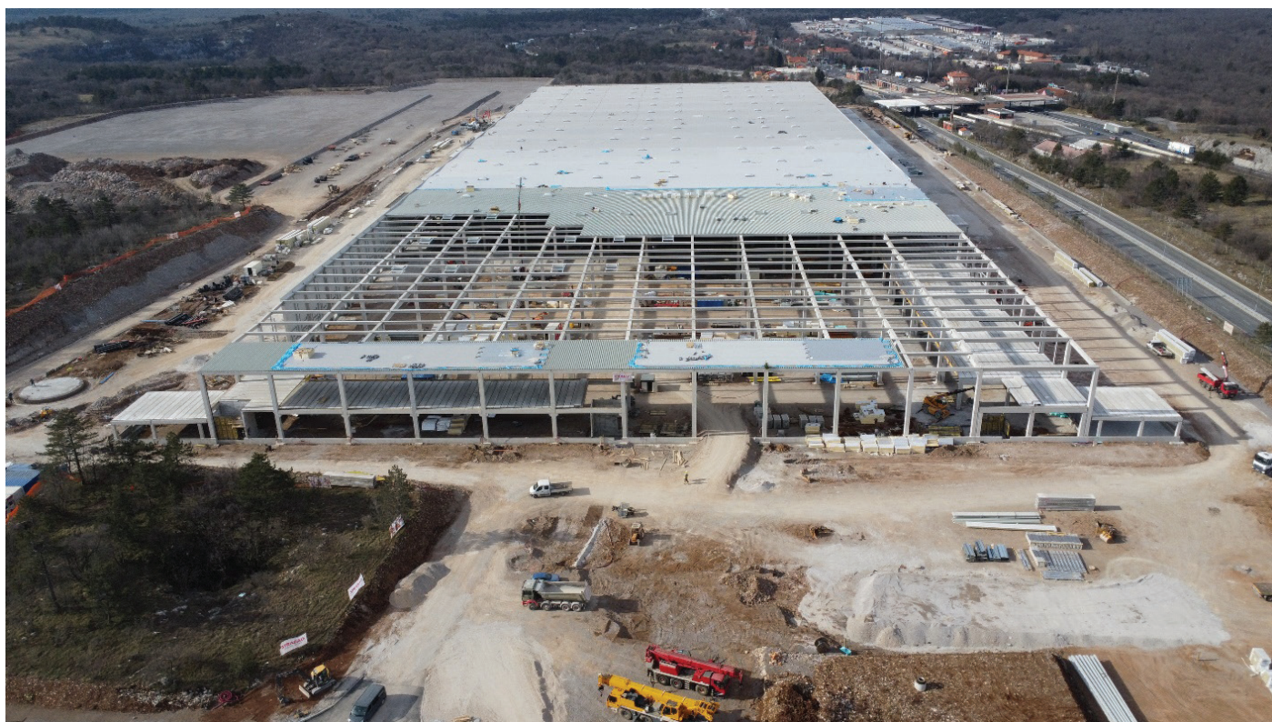
Slika 1. Logistični center TEDi Sežana v izgradnji.
