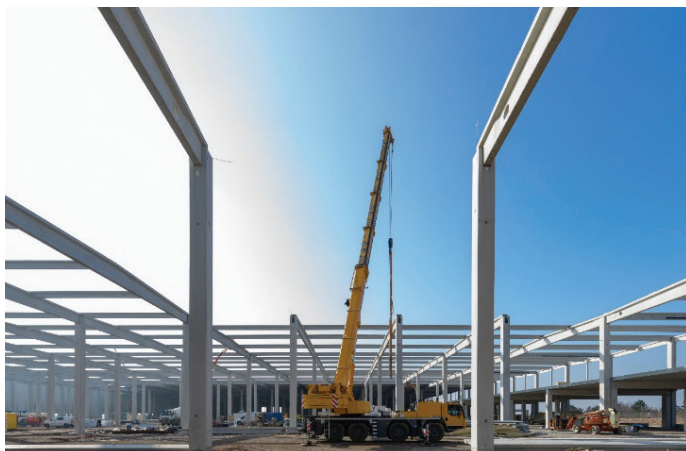
Slika 4 in 5. Montaža armiranobetonske konstrukcije.
