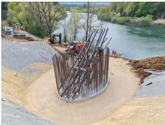
Slika 7. Vgradnja zaščitnih cevi za geotehnična sidra na vodnjaku 1, april 2022 (foto: Danilo Malnar).
