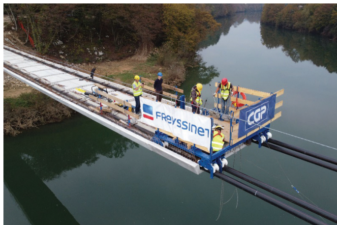
Slika 12 in 13. Vgradnja predizdelanih betonskih segmentov, oktober 2022 (foto: Ponting, d. o. o.).
