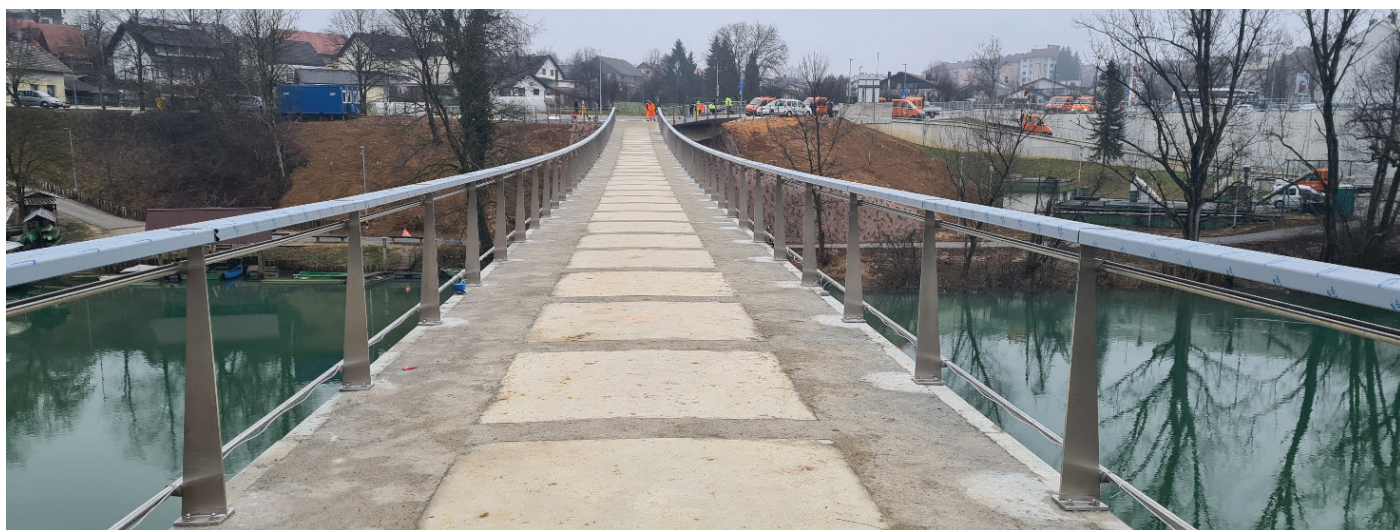
Slika 15. Voziščna konstrukcija po zabetoniranju prečnih in vzdolžnih reber, ki povežejo konstrukcijo v monolitno celoto (foto: Pipenbaher inženirji, d. o. o.).
