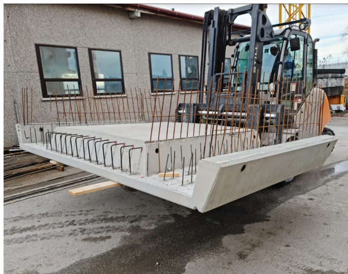
Slika 3. Pripravljen betonski segment iz delavnice, november 2021 (foto: Danilo Malnar).
