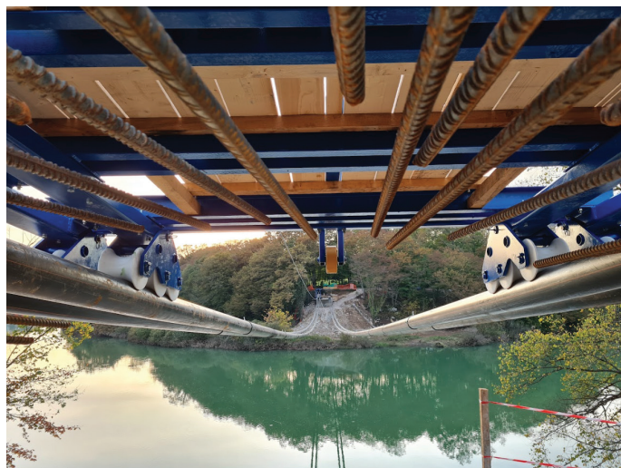
Slika 10. Pripravljene 4 zaščitne cevi z vgrajenimi kabli za napenjanje, oktober 2022 (foto: Danilo Malnar).
