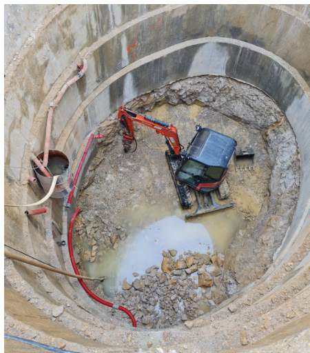
Slika 4 do 6. Izkop in vgradnja armature v vodnjak 1, marec-april 2022 (foto: Danilo Malnar).
