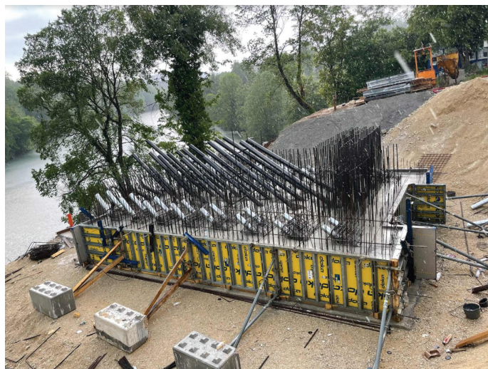
Slika 8. Zabetonirana začetna faza opornika, maj 2022 (foto: Danilo Malnar).
