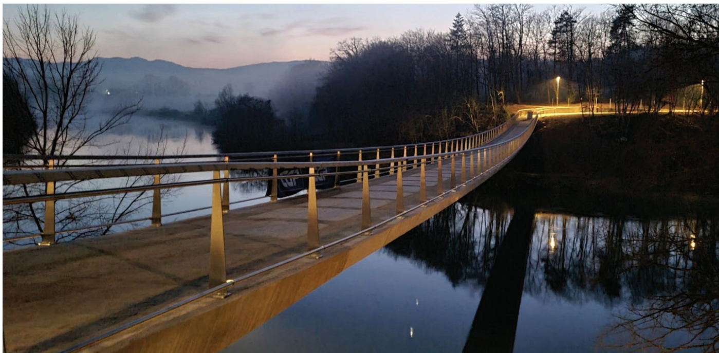
Slika 17. Pogled na most z razponom 130 m, marec 2023 (foto: Pipenbaher inženirji, d. o. o.).
