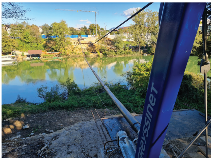
Slika 9. Vgradnja prve zaščitne cevi kablov prekladne konstrukcije, september 2022 (foto: Danilo Malnar).
