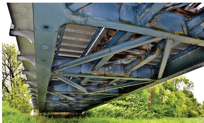
Slika 2. Pogled na spodnji del prekladne konstrukcije jeklenega železniškega mostu.
