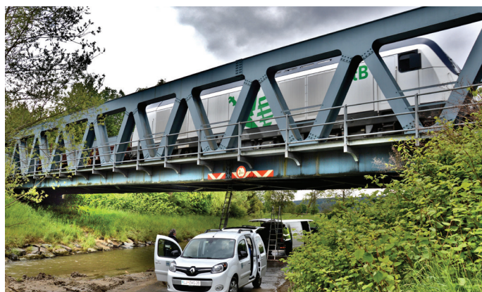
Slika 1. Stranski pogled na jekleni železniški most.
