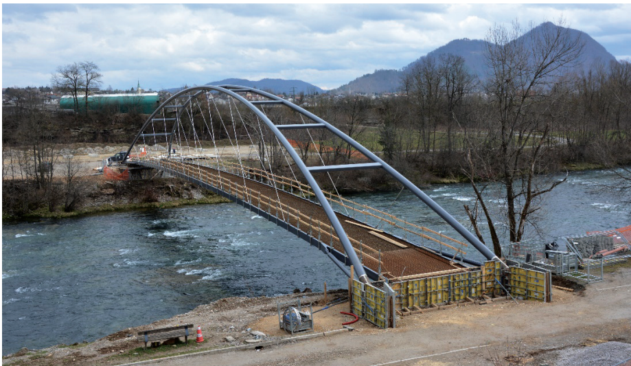
Slika 3. Primarna nosilna konstrukcija glavnega razpona (Foto: Arhiv Občine Medvode).
