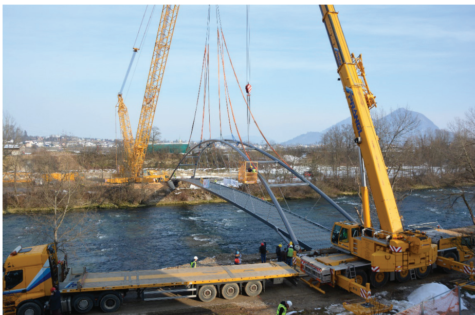
Slika 13. Primarna nosilna konstrukcija glavnega razpona na končni legi, 2. 2. 2023 (Foto: Arhiv Občine Medvode).
