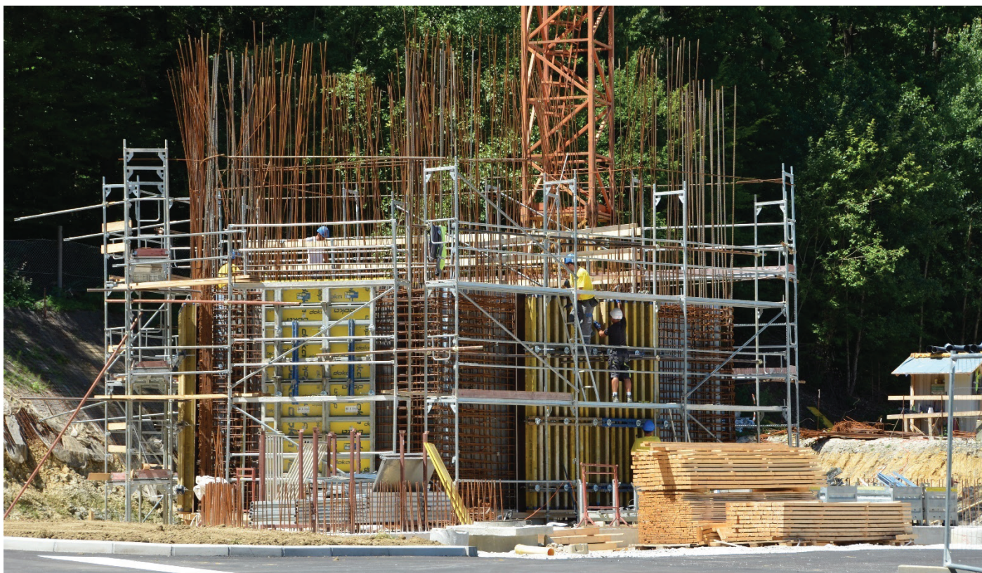
Slika 6. Opaž 1. segmenta stebra (13. 7. 2022).
