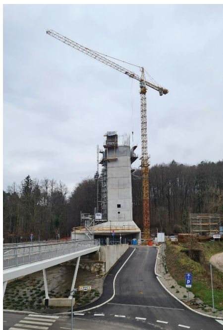
Slike 8, 9, 10. Izdelanih je 9 segmentov stebra, h = 34,65 m (10. 1. 2023).
