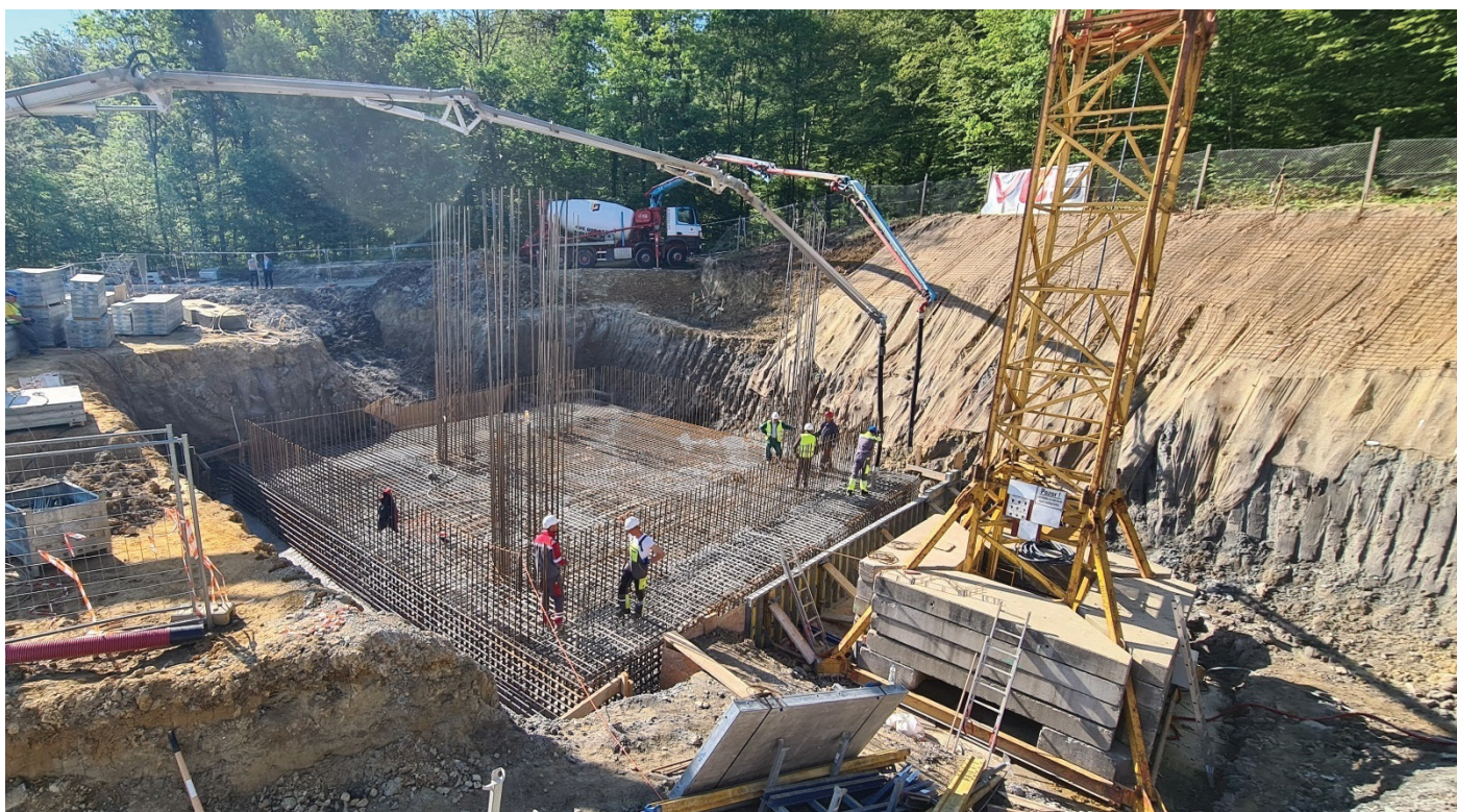
Slika 4. Betoniranje 1. faze masivnega plitvega temelja (12. 5. 2022).
