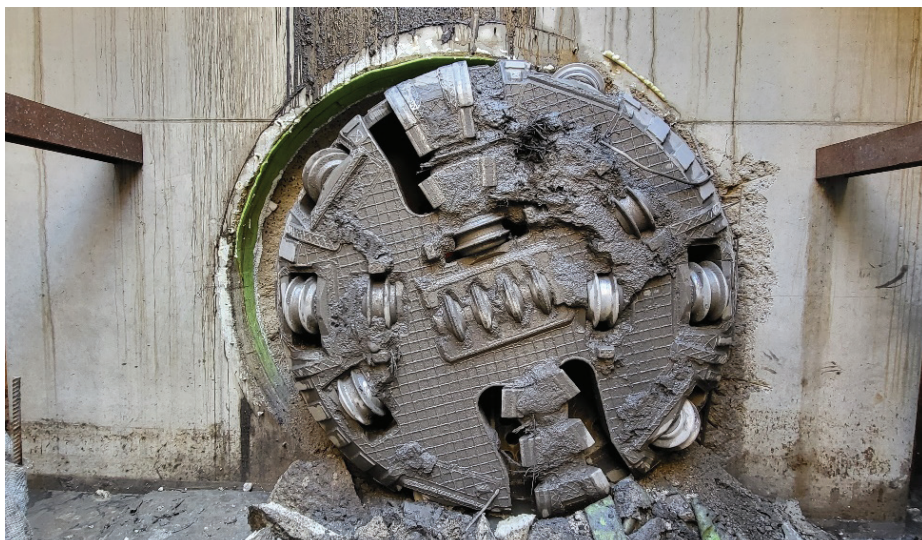
Sliki 12 in 13. Prihod vrtnice glave v izstopno gradbeno jamo in njen dvig iz gradbene jame.
