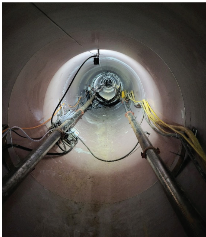
Slika 11. Pogled v notranjost cevi.
