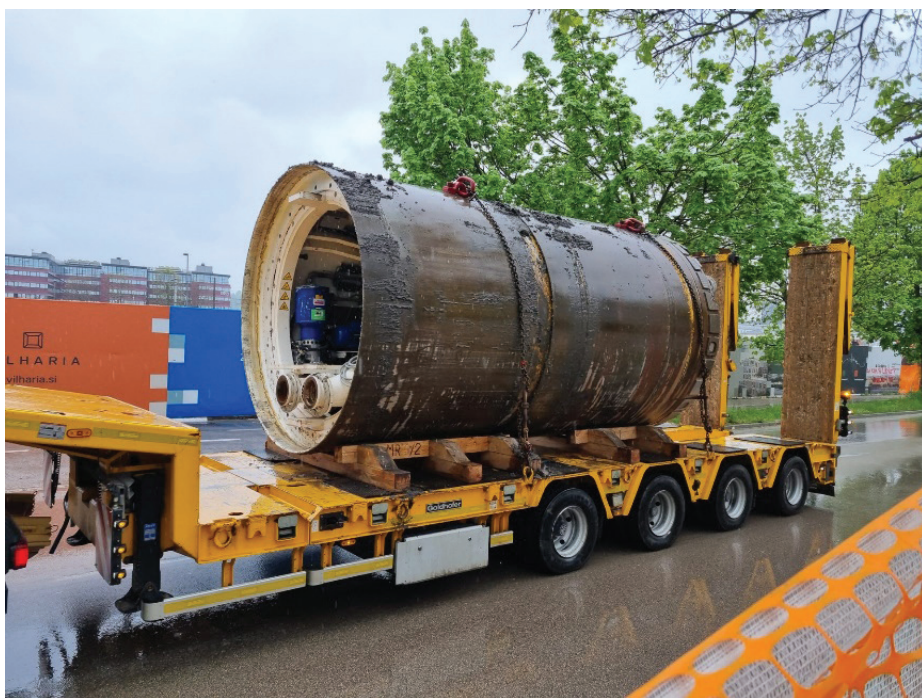
Slika 14. Transport vrtnice glave na vstopno gradbeno jamo.
