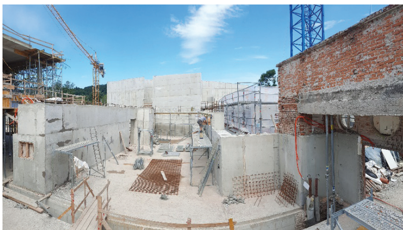
Slika 6. Statično ojačane stene objekta A, v katerega bo umeščena recepcija z Bloudkovo spominsko sobo, julij 2023.
