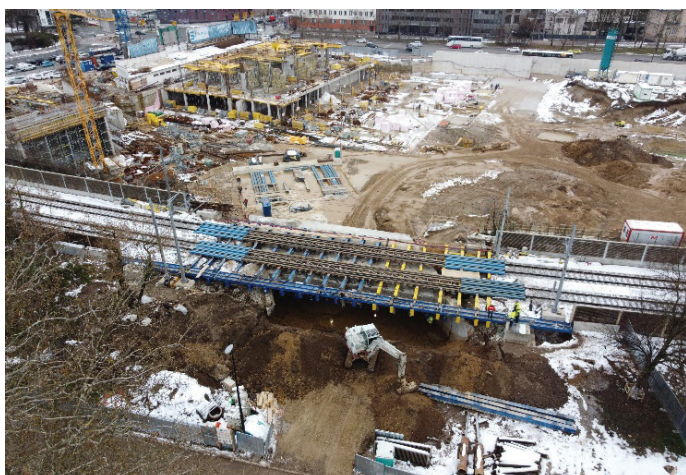
Slika 13. Izgradnja Lattermanovega podhoda v fazi podiranja, februar 2023.
