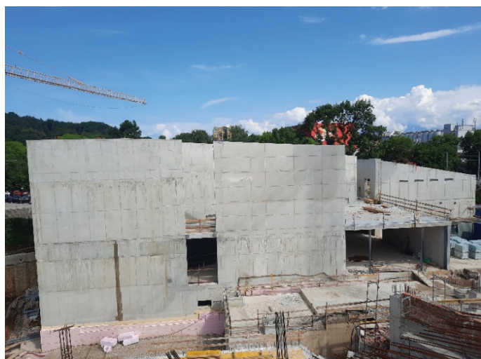
Slika 11. Dokončani vidni betoni objekta C, julij 2023.
