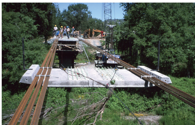
Slika 19. Montaža z vlečenjem elementov po vrveh [Stráský, 2023].
