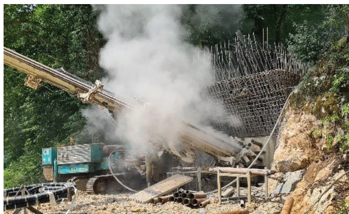
Slika 14. Vrtnje sider opornika 2.
