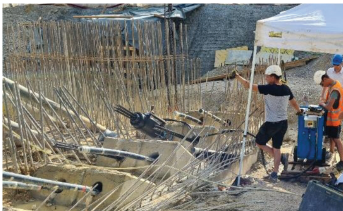
Slika 15. Napenjanje sider spodnjega nivoja opornika 1.
