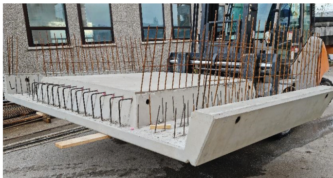
Slika 18. Predizdelani betonski element.
