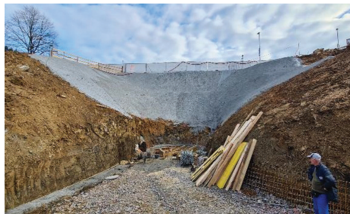
Slika 9. Pogled na torkretiran izkop vodnjaka 1.
