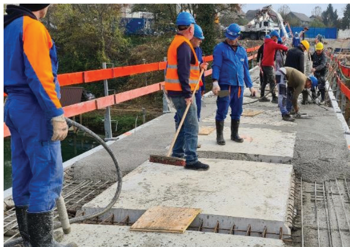
Slika 21. Betoniranje utorov prefabriciranih elementov.
