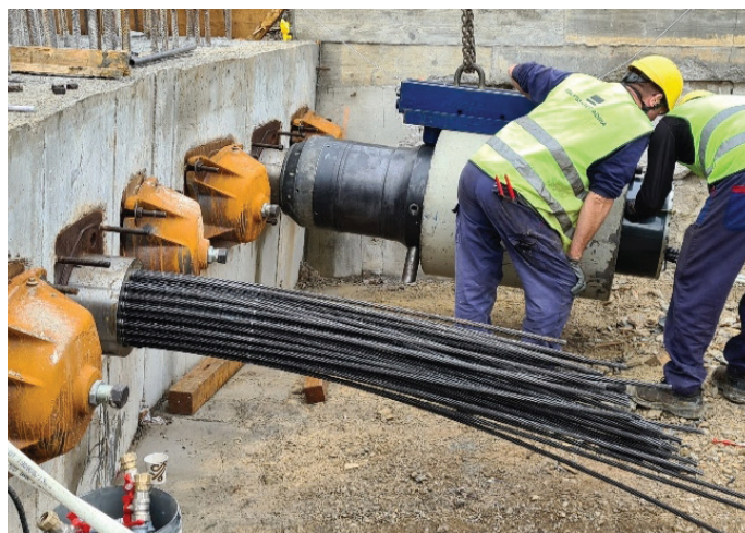
Slika 22. Napenjanje kablov 2. faze z napenjalko CC1500.
