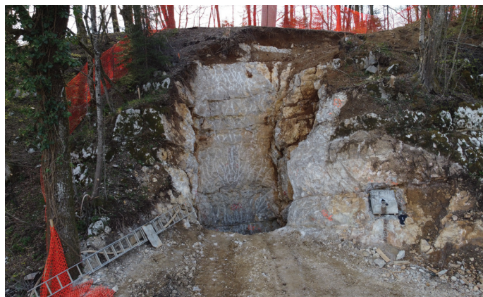
Slika 10. Pogled na izkop vodnjaka 2.
