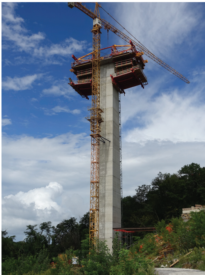
Slika 9. Dokončana montaža opreme PKG v osi 5, avgust 2023.
