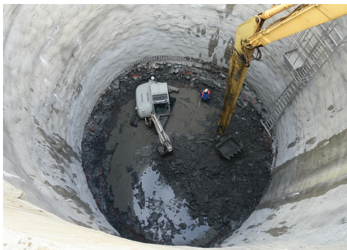
Slika 2. Izkop vodnjaka globine 16 m, zaščitene s cementnim obrizgom, november 2022.
