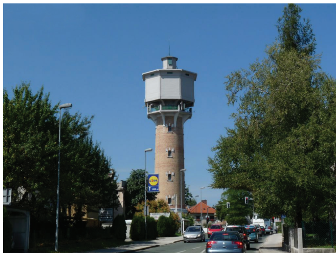
Slika 31. Vodovodni stolp v Kranju [Wikipedia, 2023d].
