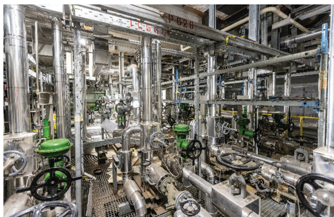
Slika 11. Polna notranjost tehnološkega objekta, avgust 2023.
