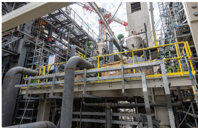
Slika 8. Zahtevna montaža cevovodov in tehnološke opreme, junij 2022.
