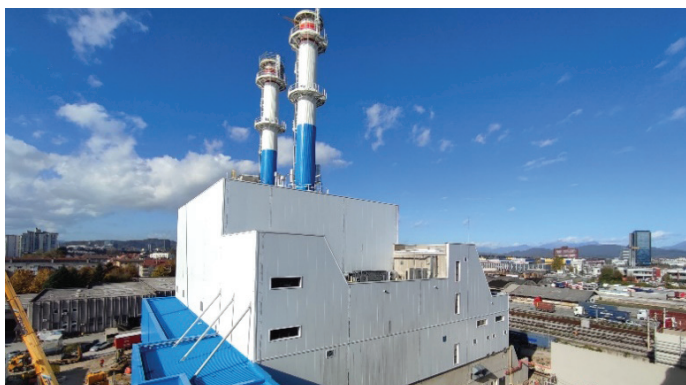
Slika 15. Glavni tehnološki objekt z jugovzhodne strani, september 2023.
