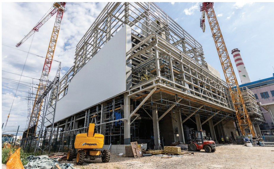
Slika 7. Pričetek izvedbe fasade, junij 2022.
