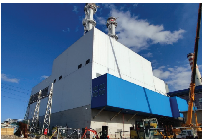
Slika 14. Glavni tehnološki objekt z jugozahodne strani, junij 2023.
