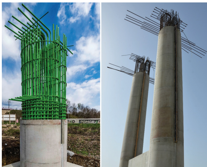
Slika 21. Testni steber in izveden steber z razcepljenim delom višine 8 m.
