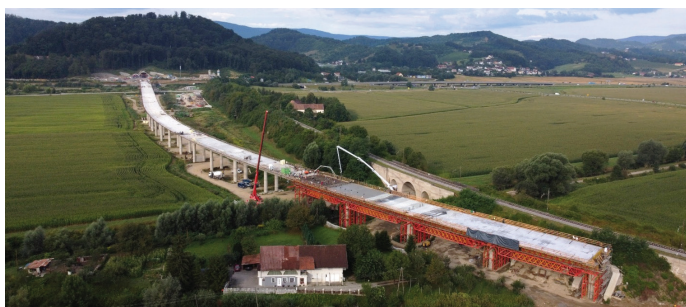
Slika 23. Zaključek betoniranja predzadnjega takta.
