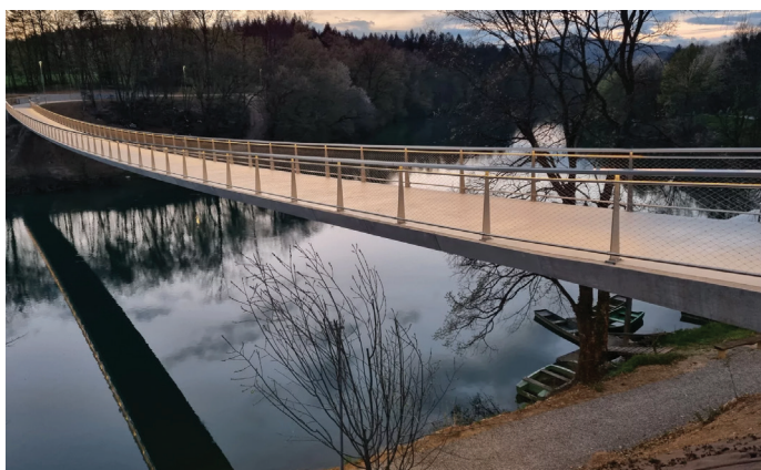
Slika 1. Most čez reko Krko, zgrajen po tehnologiji natezних trakov [Freyssinet, 2023]
