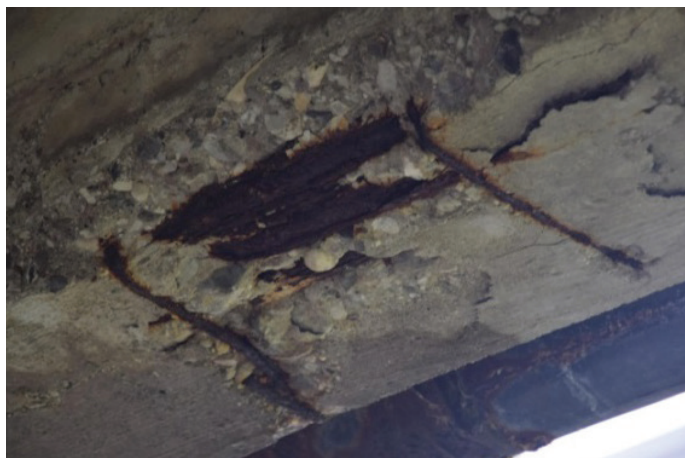
Slika 2. Odpadanje zaščitnega sloja betona in korozija nosilne armature
