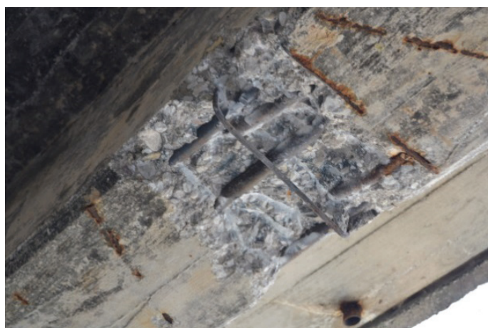
Slika 3. Določitev položaja in količine armature s profometrom (levo) in udarnim vrtalnikom (desno)
