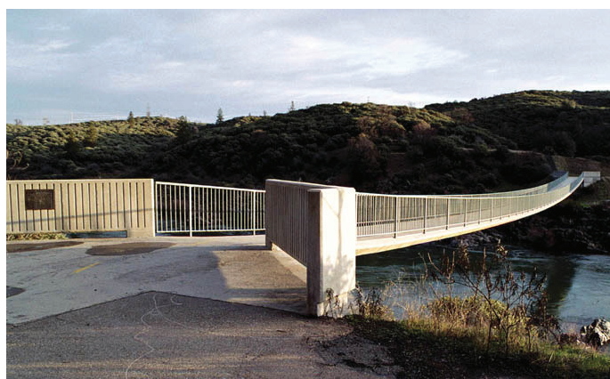
Slika 2. Prikaz obravnavanega mostu Sacramento River Pedestrian Bridge [Structurae, 2025]
