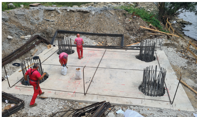
Slika 9. Priprave na izvedbo temeljne plošče
